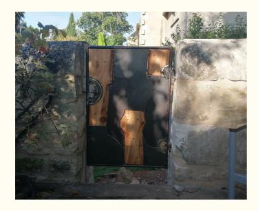
**Portillon** chez un particulier. Réalisation par Sandra. Assemblage tôles et planches de chênes. Incorporation roulements et engrenages.
